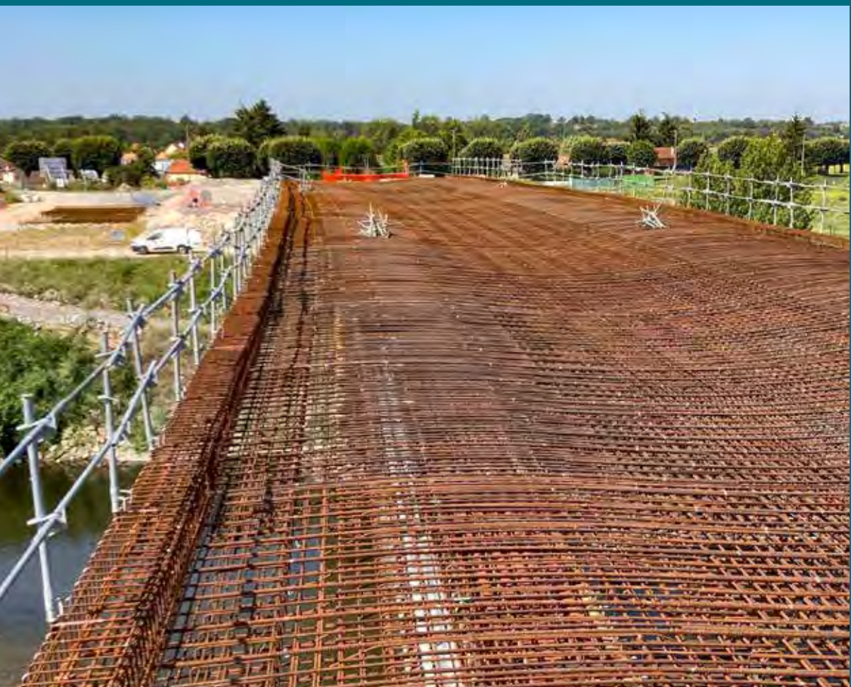
Armature du tablier de l'ouvrage principal.
