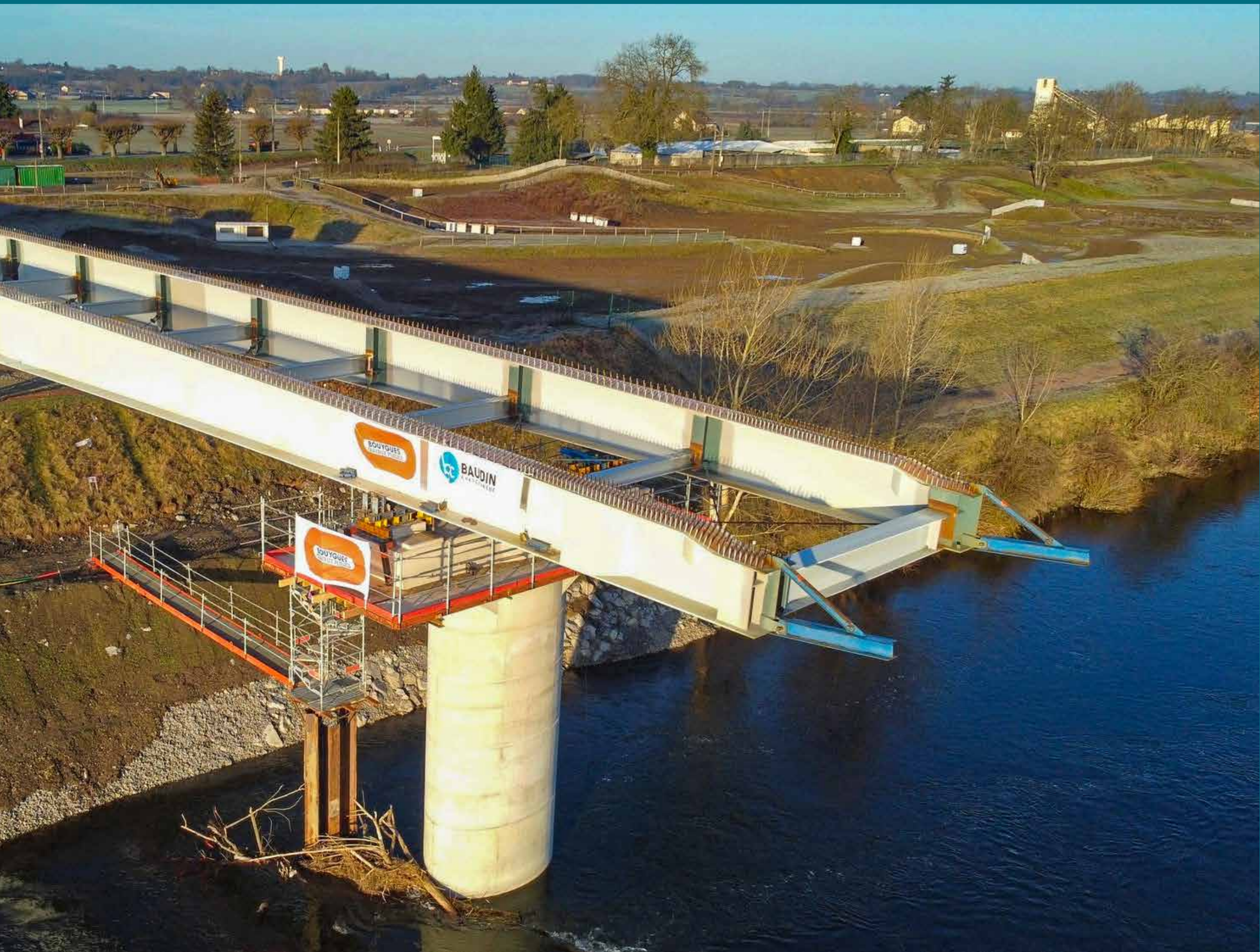
Lancement de la charpente métallique du second pont routier, Moulin.
