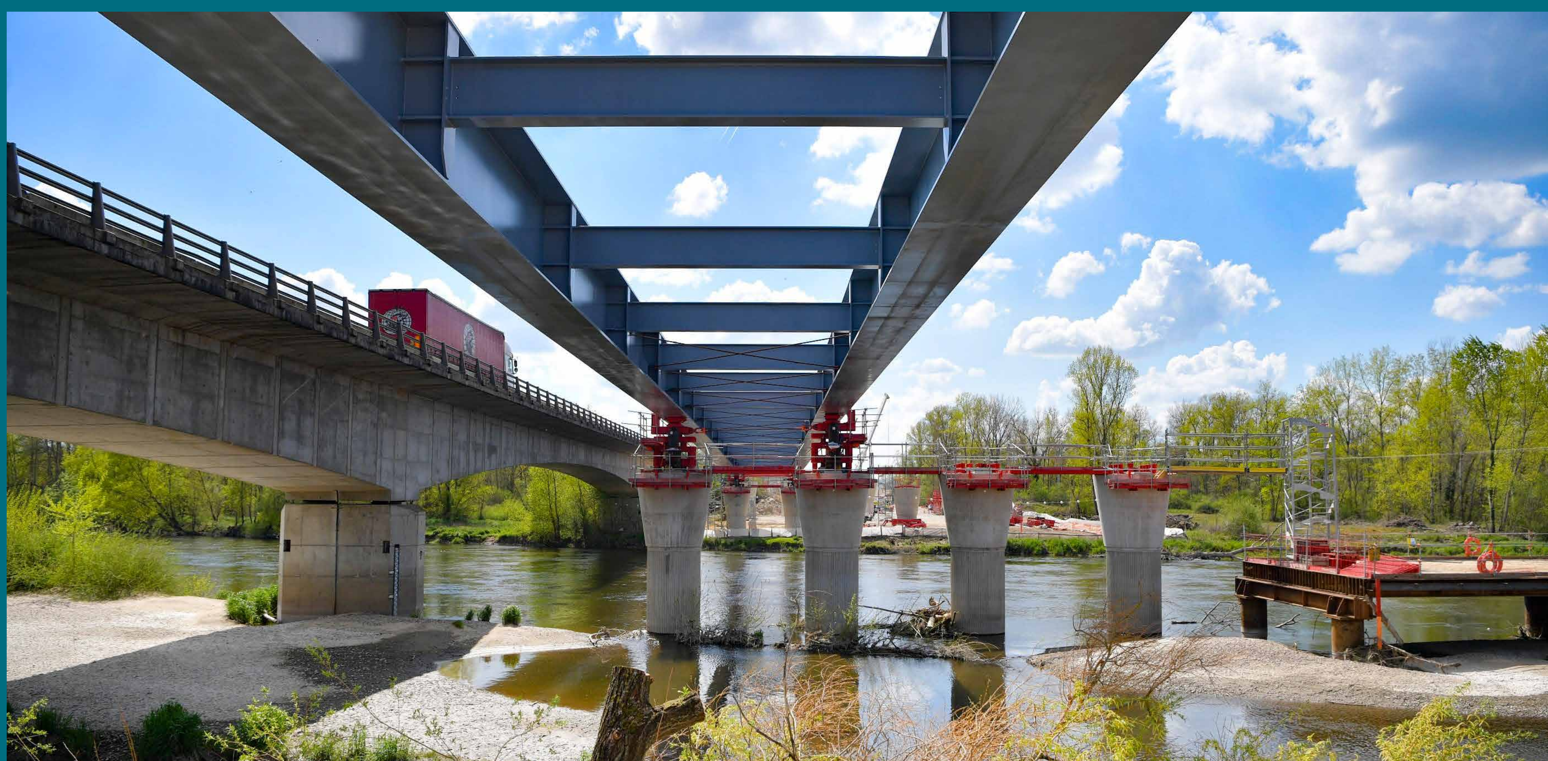
Lancement de la charpente métallique du viaduc de l'A79 au-dessus de l'Allier. © François-Xavier Gutton, La Montagne Centre France
