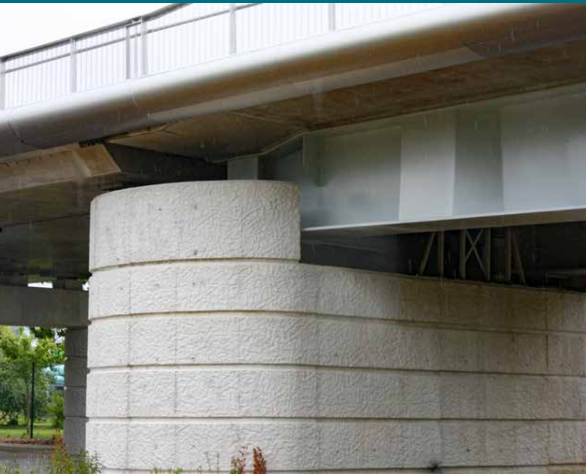
Appui de liaison entre les deux ouvrages du pont.
