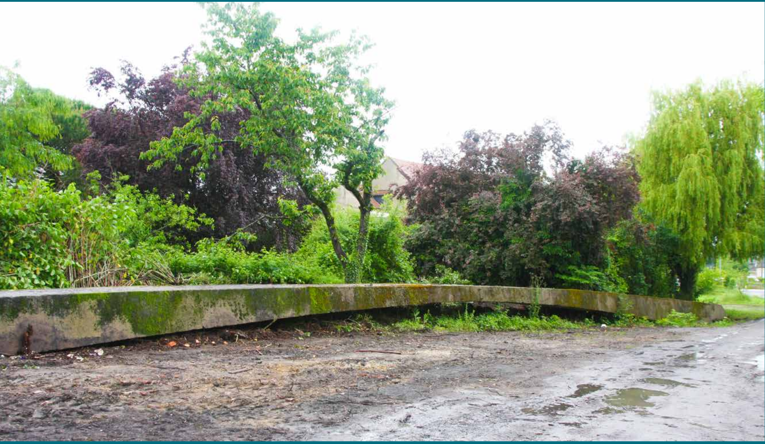
Arche d'essai Freyssinet, Moulines. Le tirant-buton est sous terre, seules l'arche et les culées sont aujourd'hui visibles. © Moulines Communauté
