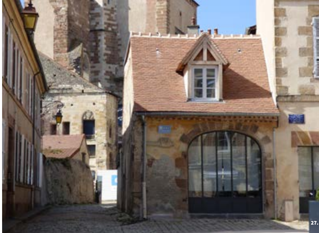
27. Toiture refaite en tuile plate
