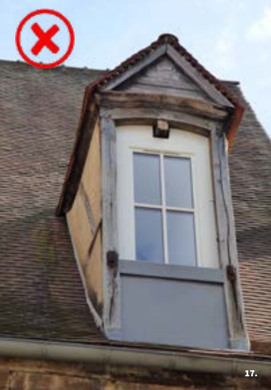
17. Menuiserie PVC avec larges placages sur une lucarne ancienne
