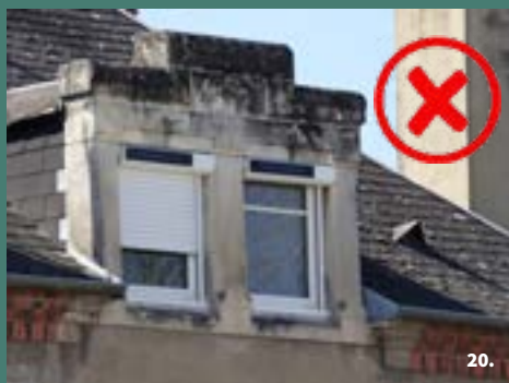
20. Menuiseries PVC, volets roulants à bacs apparents, sur une façade de la fin du XIXe siècle
