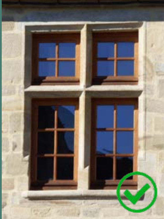
18. Menuiseries en bois à petits carreaux sur une fenêtre à croisée et meneaux
