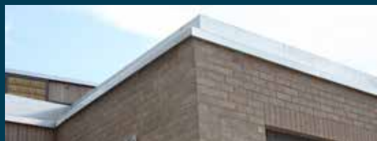
20. Calepinage des briques et acrotère, détail
