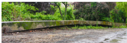
Arche d'essai Freyssinet, Moulins. Le tirant-buton est sous terre, seules l'arche et les culées sont aujourd'hui visibles.
