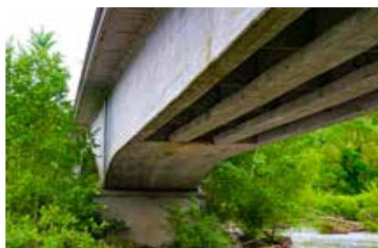
Pont Cantilever, Le Veurdre.
