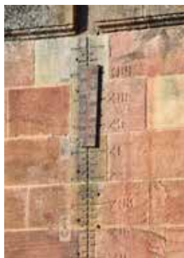
Échelle limnimétrique, pont Régemortes.
