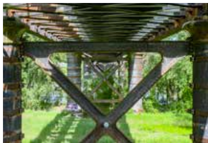
Détails du pont de fer, Moulins.
