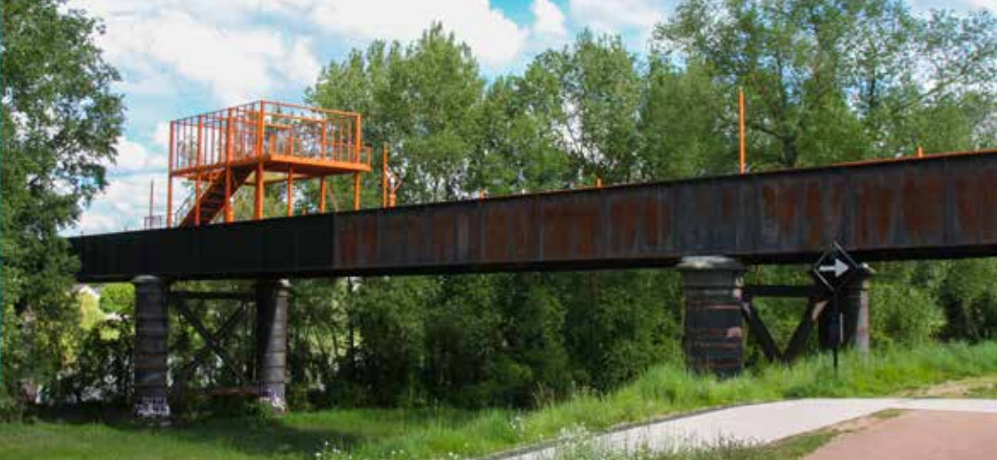
Pont de fer, Moulins.
