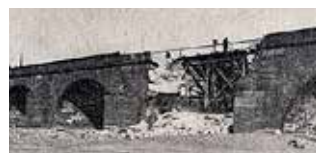
Sabotage du pont Régemortes, juin 1940.
