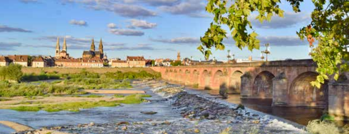
Vue de la risberme en aval du pont Régemortes.
