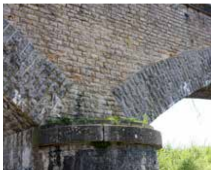
Pont sur la Loire, Gannay-sur-Loire, détail.
