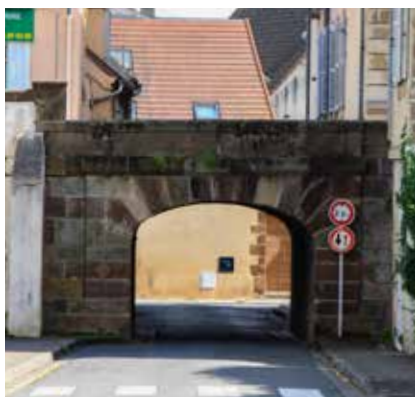
Pont sur la rue du rivage, Moulins.
